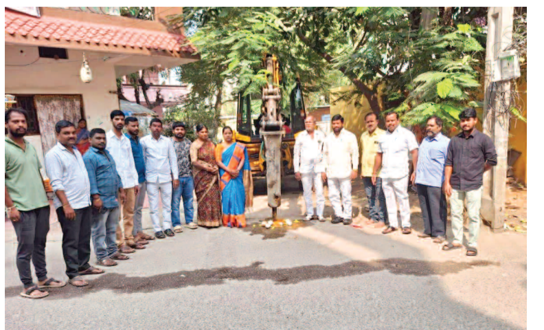
సీసీ రోడ్డు పనులను ప్రారంభిస్తున్న కార్పొరేటర్ మోండ్ల సంగీత గౌరీ శంకర్
