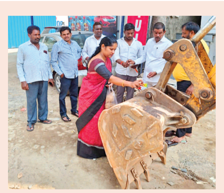
రోడ్డు పనులను ప్రారంభిస్తున్న కార్పొరేటర్ ఎం సంగీత్ అత్తాపూర్ డివిజన్లో రాండ్లు పనులు ప్రారంభం
